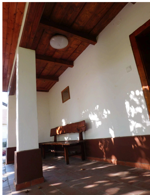
A felújított tájház tornáca
